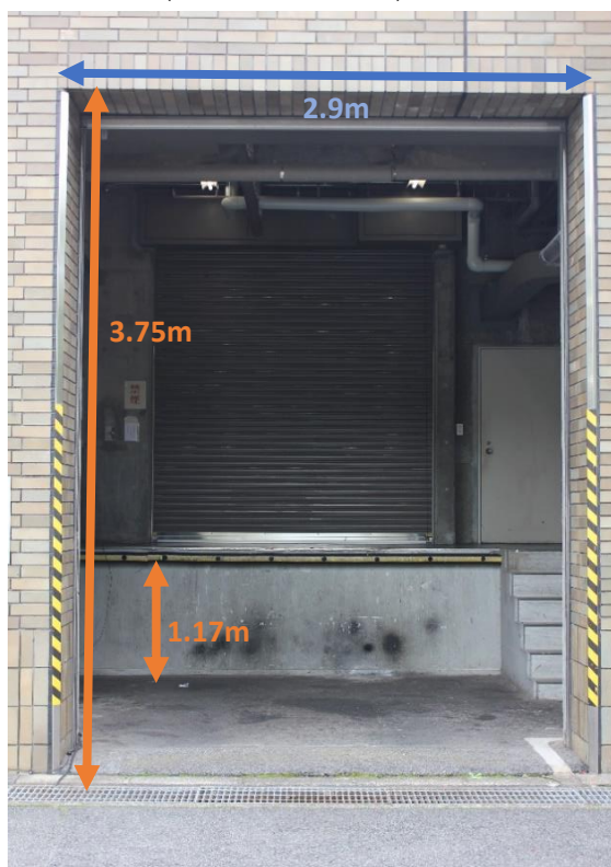
▼搬入口（外側シャッター）
